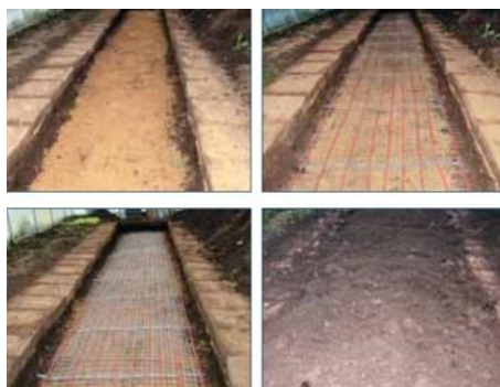
Рис. 4. Технологические операции по установке нагревательных кабелей
