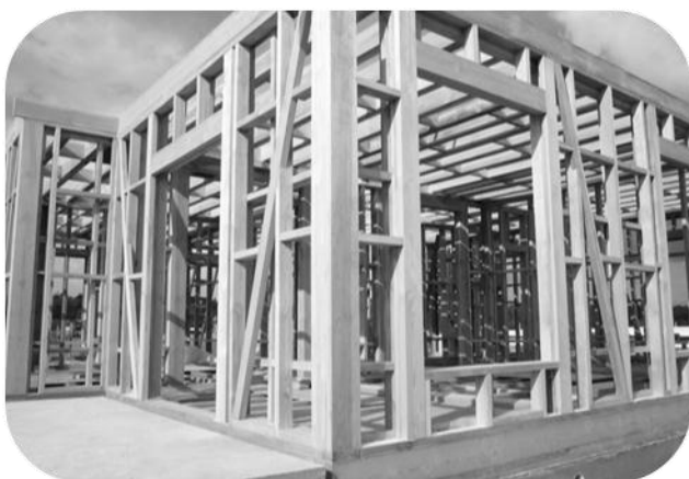
Рис.1 Несущий остов двойного объемного каркаса
