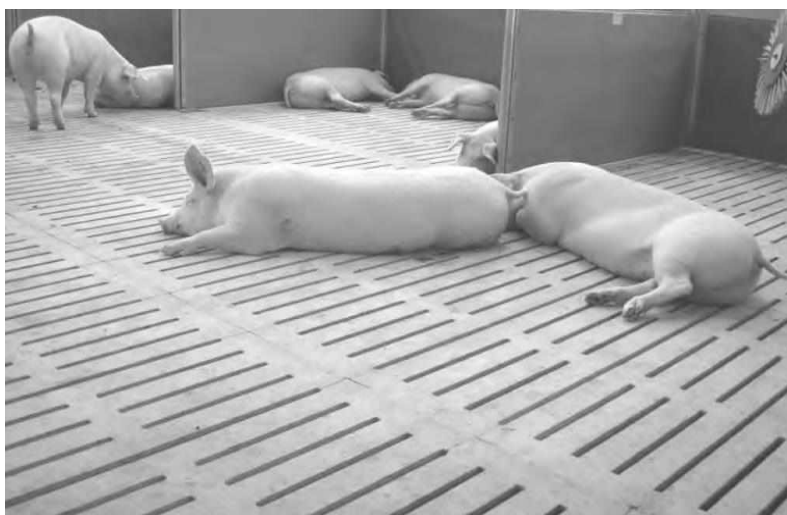
Рисунок 7– Бетонный щелевой пол
