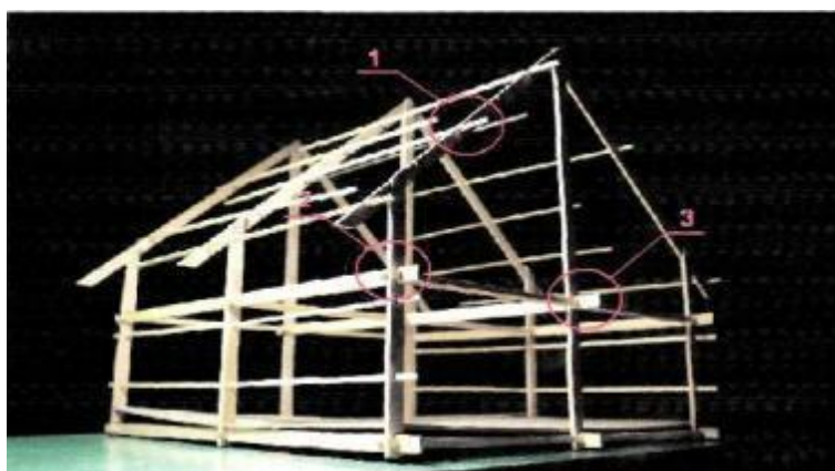
Каркас жилого дома и узлы по технологии «Деметр»
