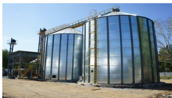
Аэрируемые бункера для хранения зерна и солода на 1000т с канально-раструбной системой вентиляции (п.Рошино Челябинской области, 2012г.)
