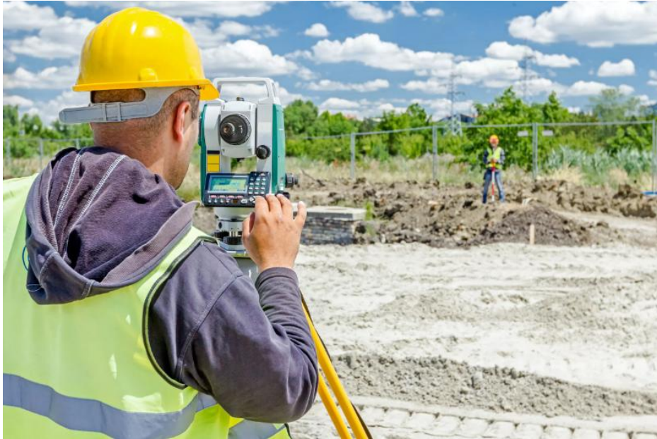
Рис. 3. Процесс выполнения разбивочных работ на площадке
