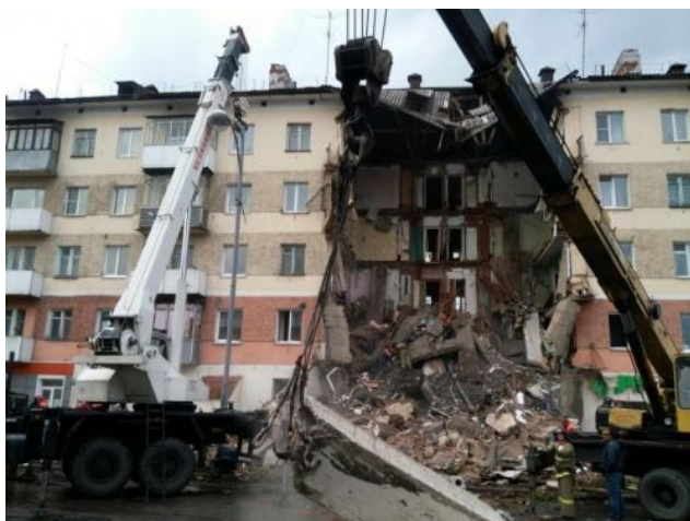
Рис. 1. Разрушение подъезда жилого здания
