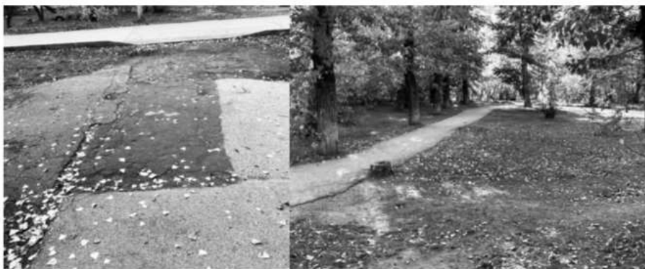
Рисунок 4. Состояние дорожно-тропиночной сети
