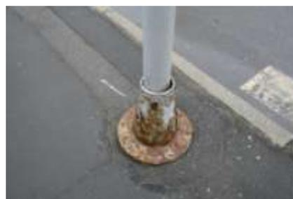
Рисунок 1. Пример влияния химических реагентов на металлические элементы обустройства дорог
