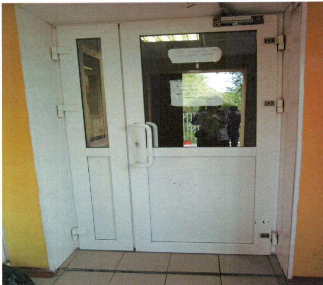
Фото № 7 Дверь (входная)
