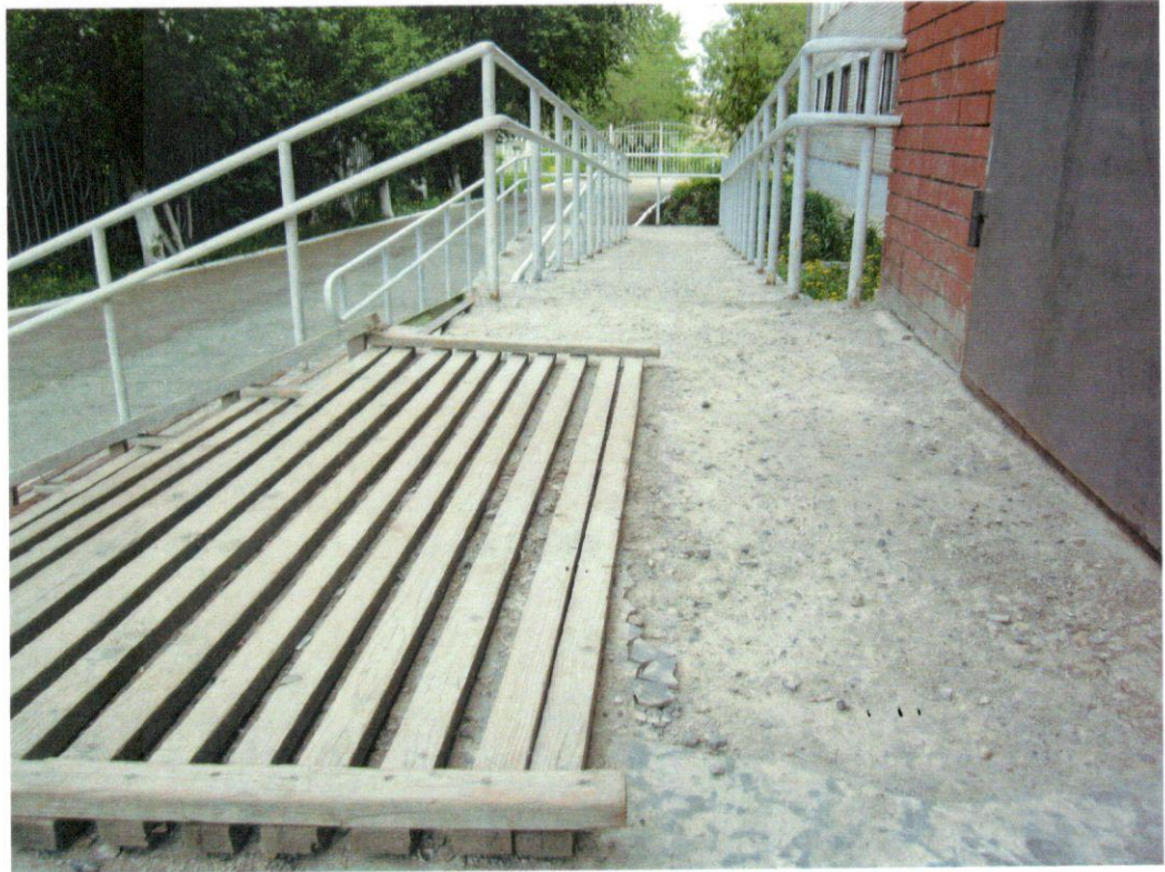
Фото № 5 Входная площадка (перед дверью)
