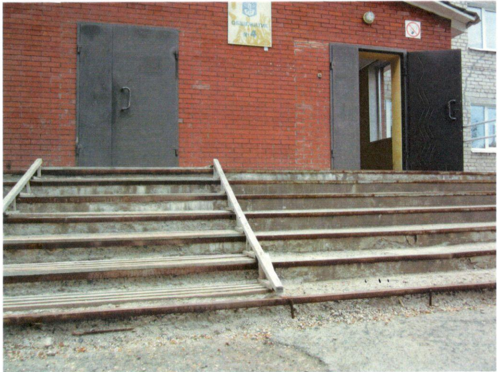
Фото № 3 Лестница (наружная)
