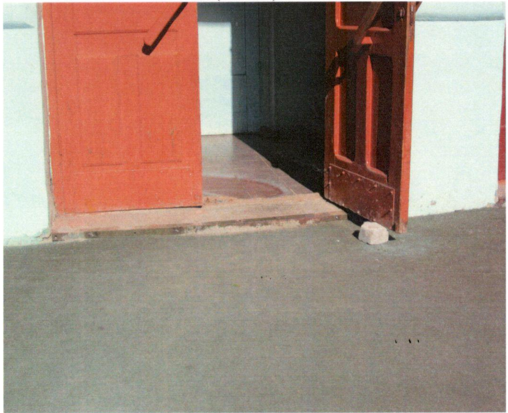
Фото № 2 Дверь входная
