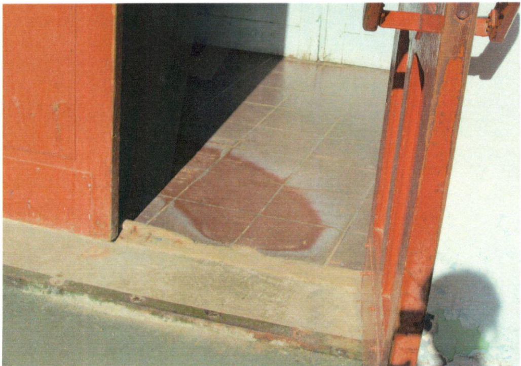
Фото № 3 Входная площадка (перед дверью)
