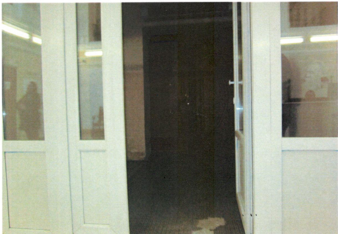
Фото № 9 Тамбур (главного входа)
