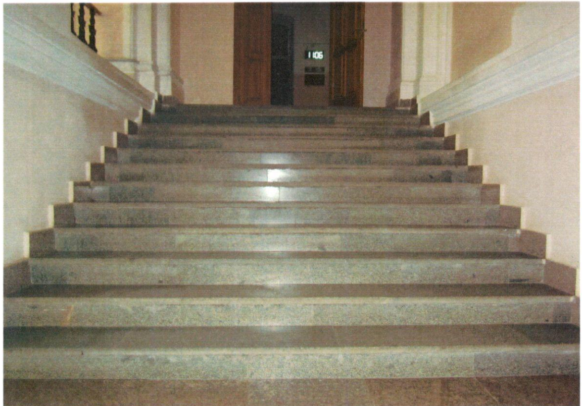
Фото № 16 Лестница (внутри здания)
