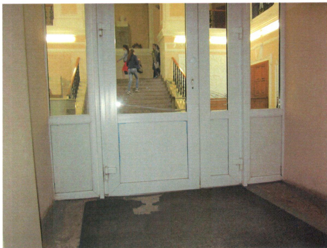
Фото № 10 Тамбур (главного входа)
