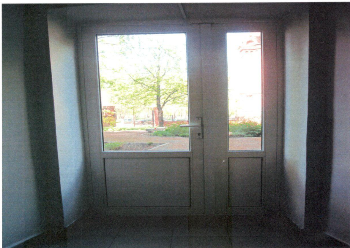
Фото № 18 Пути эвакуации 29
