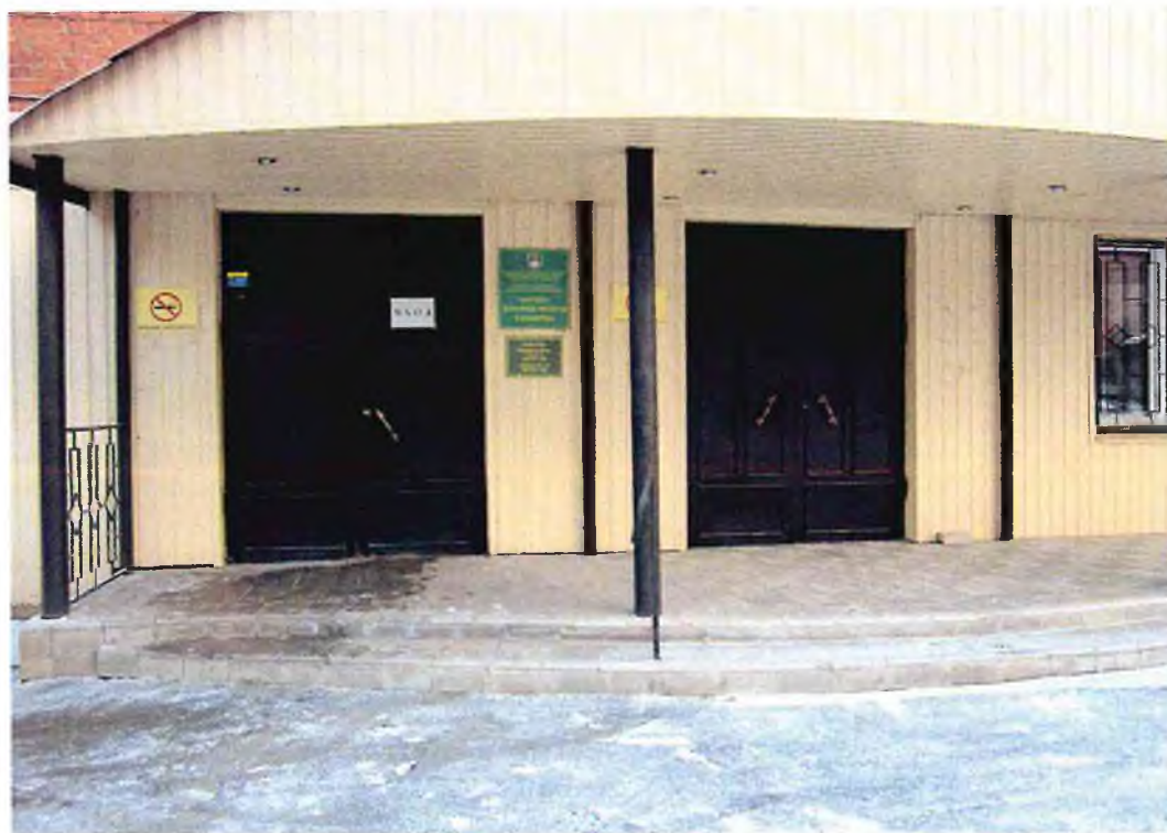
Фото 3. Вход (входы) в здание
