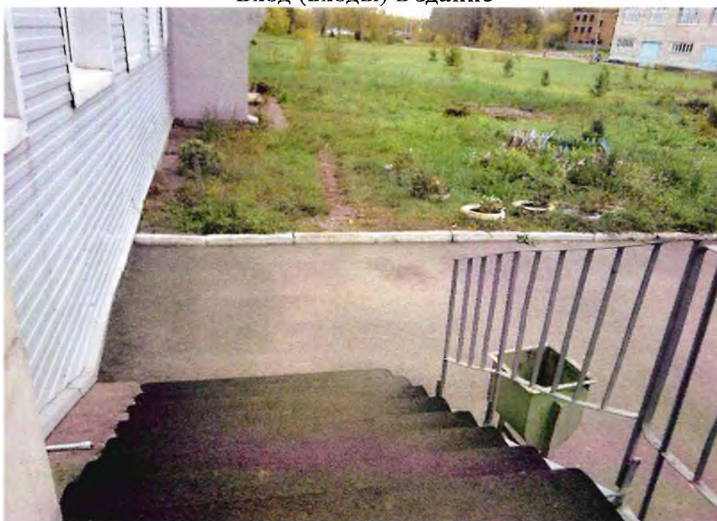
Фото 2. Лестница около главного входа
