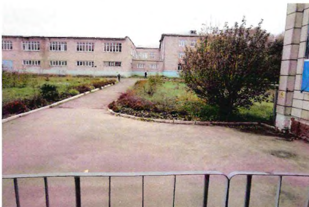
Фото 1. Территория, прилегающая к зданию (участок), место для автомобильной стоянки и парковки
