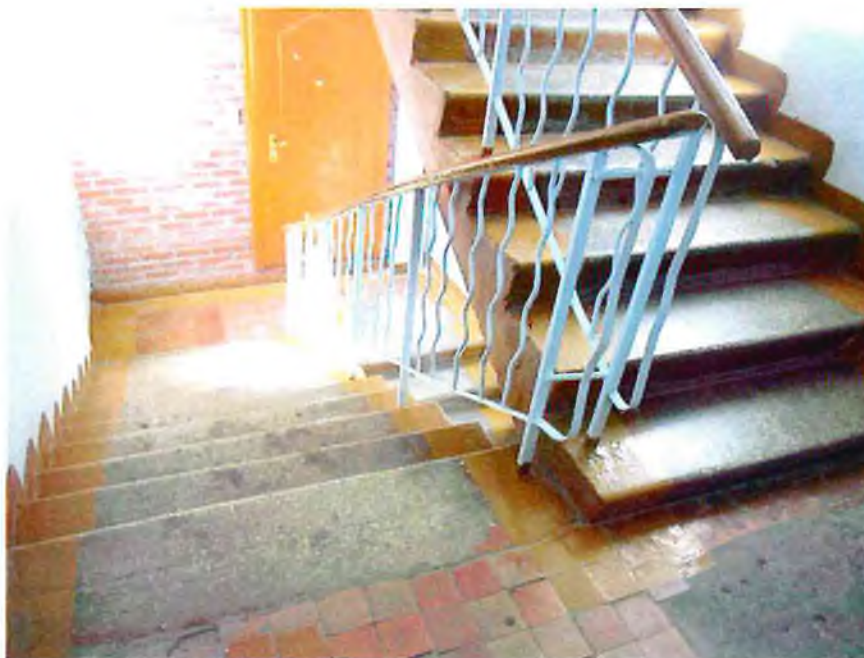
Фото 5. Лестница (внутри здания)
